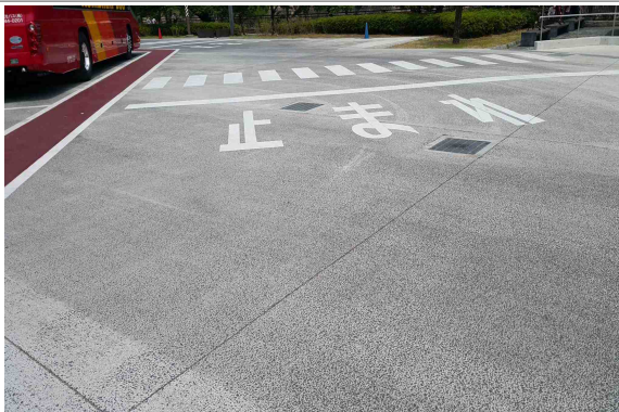
주차장 반강성 포장
