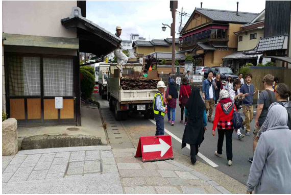
상차작업 신호수 복장 및 안전시설
